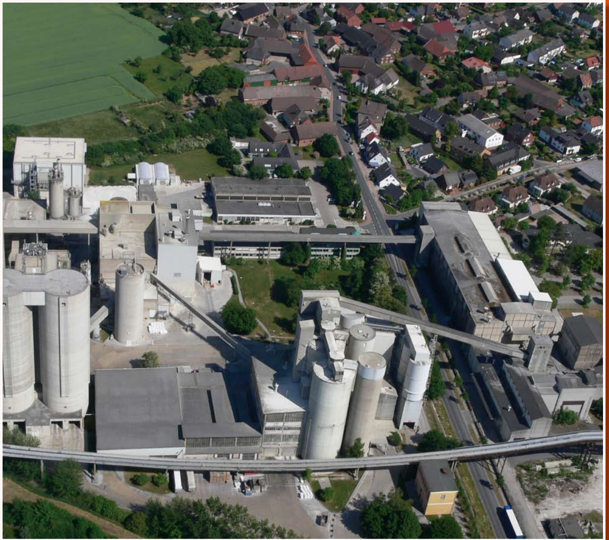
Das Zementwerk befindet sich südlich und nördlich der „Hannoverschen Straße“. Ein Teil der Gebäude, die rechts zu sehen sind, stammen noch aus der Zeit der Gründung des Werkes im Jahr 1908.
