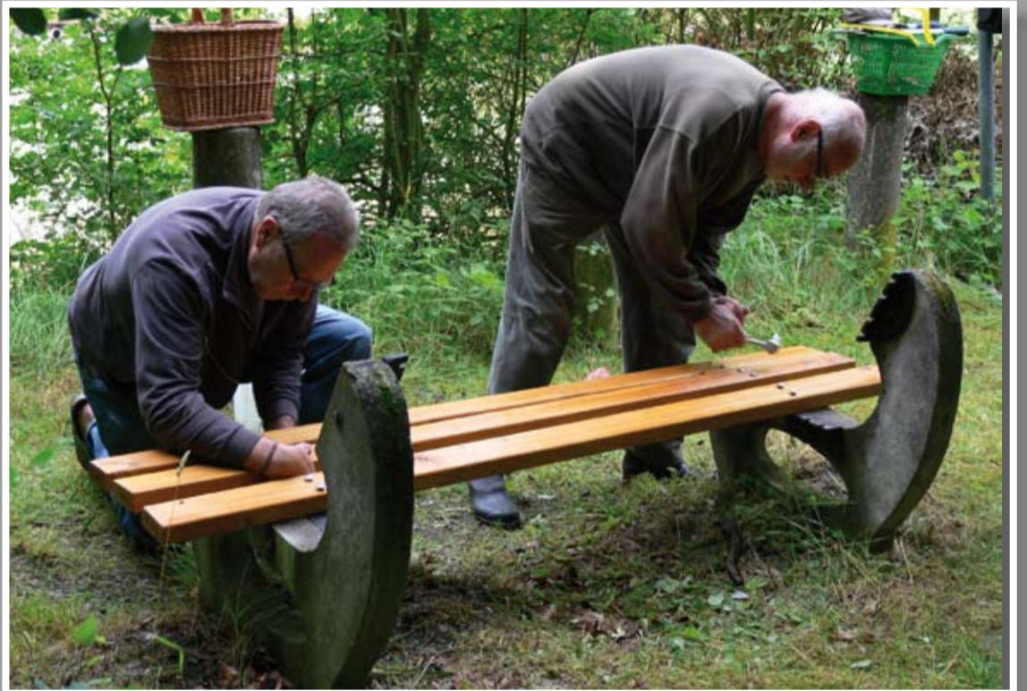
Reparatur der Bank an der Kanalbrücke 2014.
