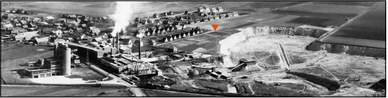
Das Zementwerk „Alemannia“ in einer Luftaufnahme aus dem Jahr 1955. Die steilen Abbauwände des damaligen Steinbruchs zeigen, der Mergel wurde durch Sprengungen gelöst. Reißraupen gab es nicht. Die Dreieckspitze (Bruchstraße/Ecke Alemanniaweg) zeigt den Standort des Fotografens für die unten stehende Farbbildung.
